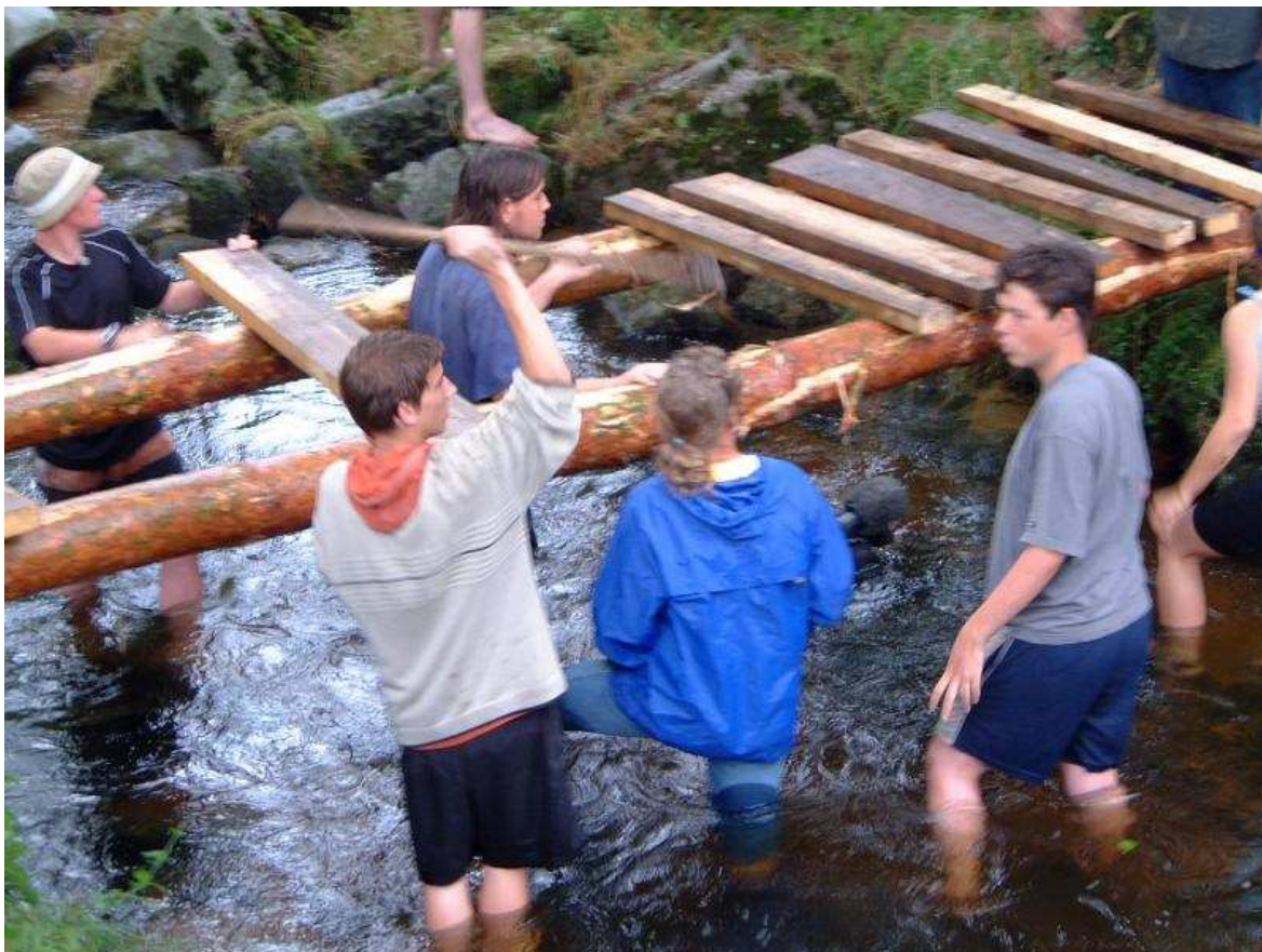
Stavba „evropského mostu mládeže“ – Cetviny (červenec 2002)
